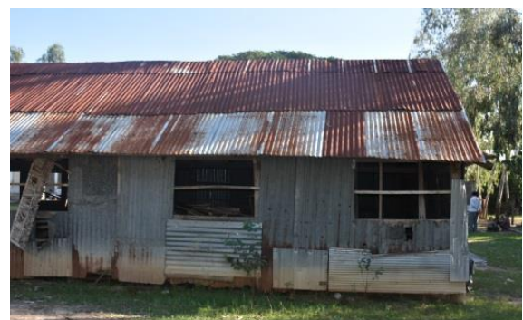
テックチュー幼稚園・小学校 建替え予定校舎裏
