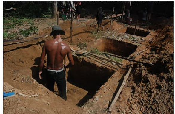
学校建設作業中
