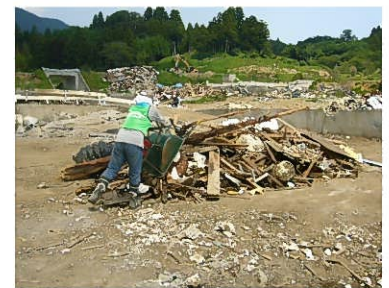
瓦礫の片付け
