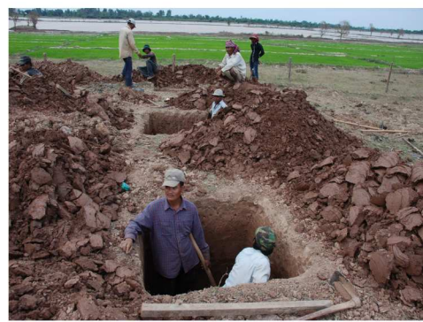
ようやく基礎工事が始まった学校
