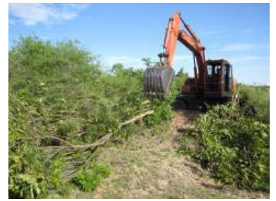
整地作業の様子
