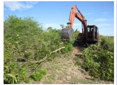
整地作業の様子
