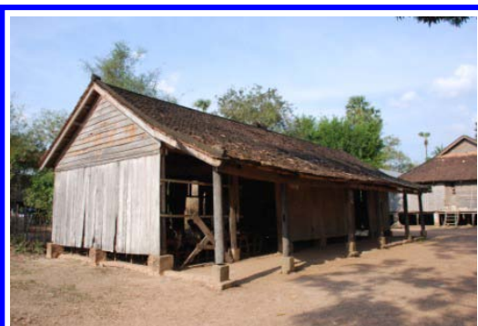
プレハニャンクー小(2009年2月撮影) 柱・梁・屋根とも大変老朽化しています
