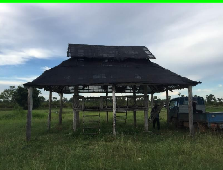
張り替えた休憩小屋
