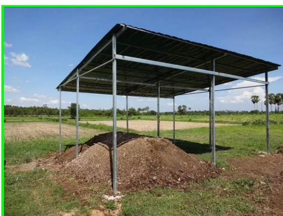
完成した堆肥場と積み上げた堆肥。全て自分たちの手で行いました。
