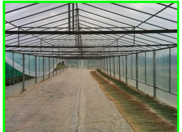
完成した乾燥ハウス内部。ビニール入手に時間がかかったり雨に足止めされたりしましたが、完成しました。
