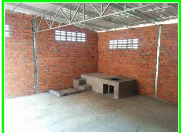
蒸留棟の内部。右奥にあるのが蒸留の為のかまど、その左に洗浄場所を作成中。
