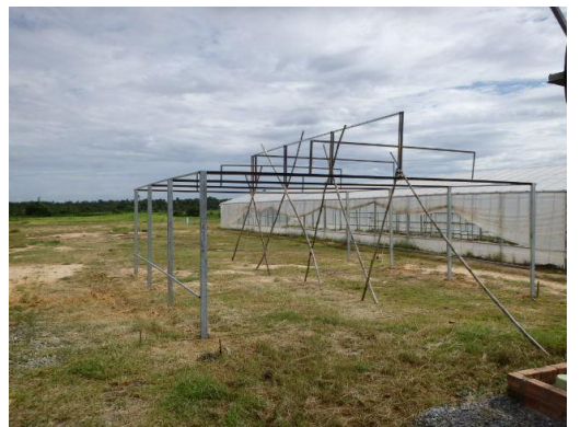
野菜栽培用にハウスの建設を行っていきます。
