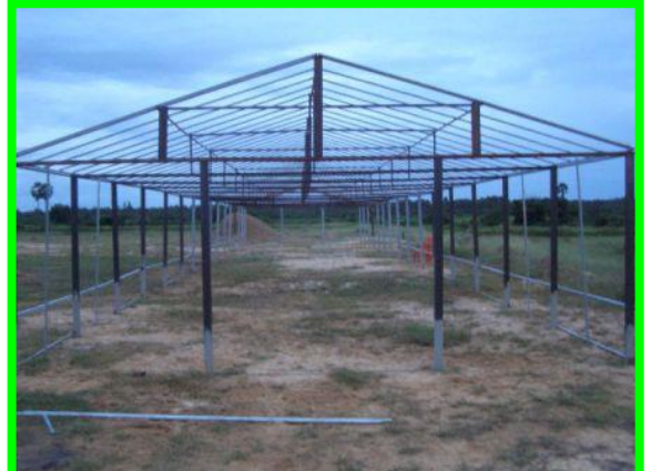
完成したビニールハウスの骨組み
