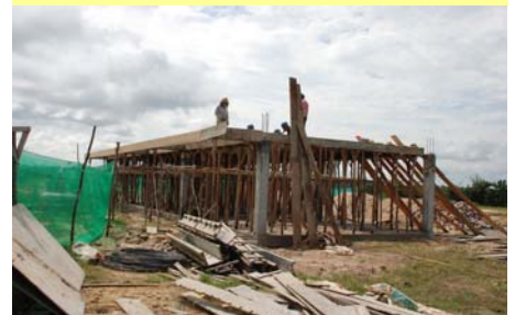
建設中の宿舎
