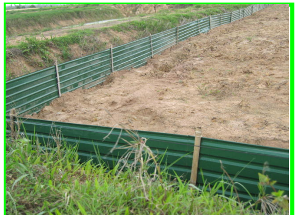
モデル区の水田に壁のように埋められたトタン。
