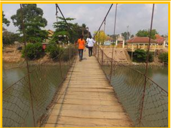
車の通れない吊り橋を歩いて家まで送ります
