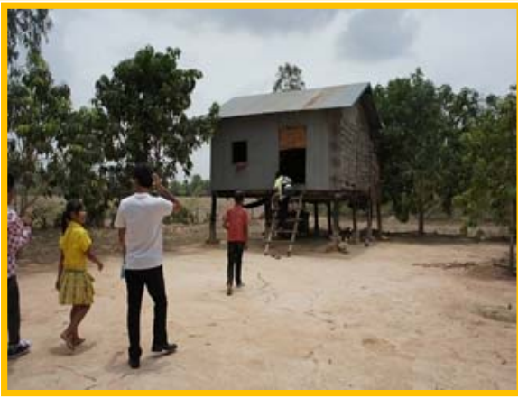
壁と屋根がトタンで出来た、高床式の家
