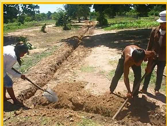
配水管を埋める溝作り
