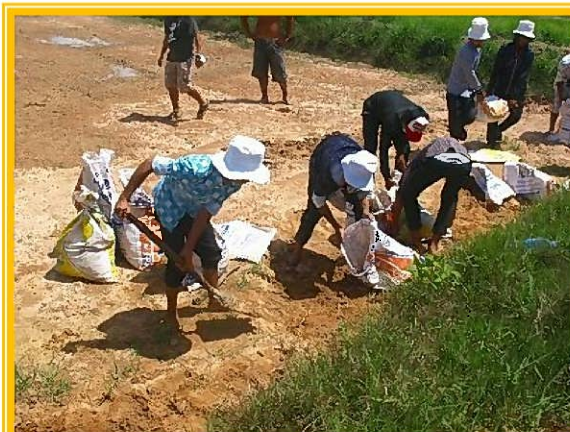
崩れた道路の補修
