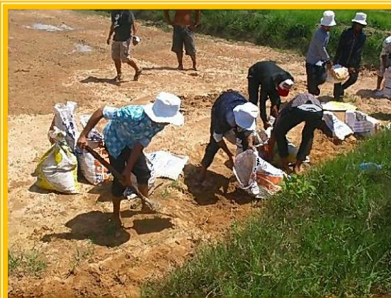
崩れた道路の補修
