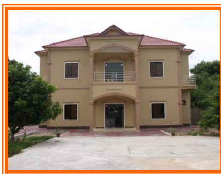
完成した2階建ての宿舎。
