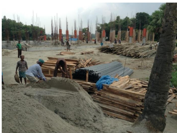
NDMHS 本校舎建設現場
